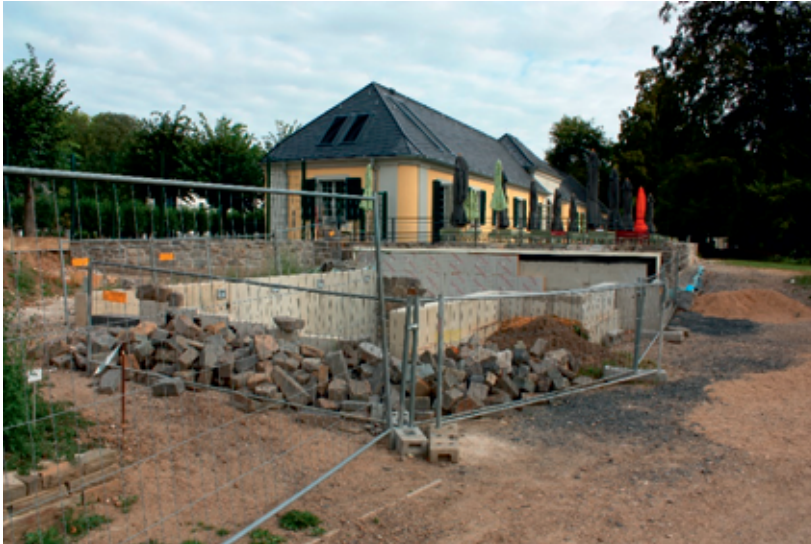
Zustand Anfang August 2016...
