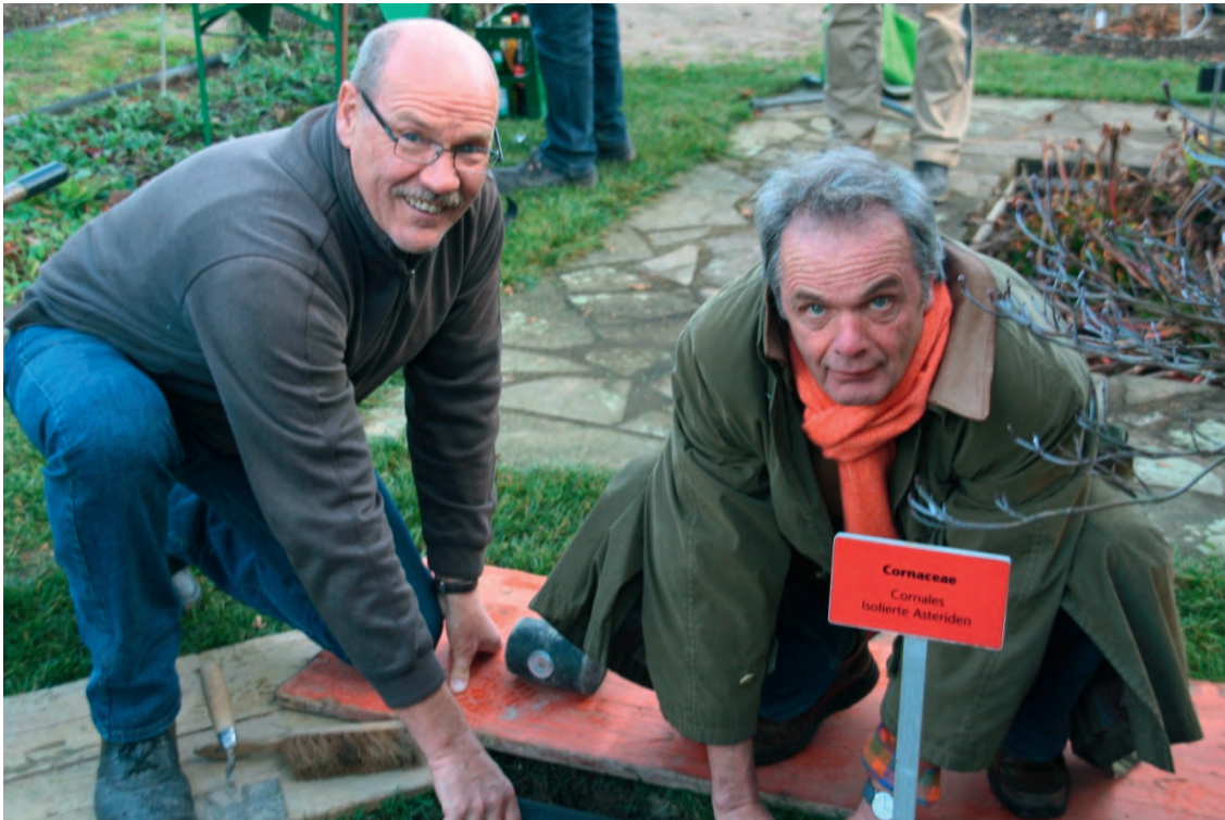
Unser Sponsor, Helmut Neuerburg setzt, unterstützt durch Manfred Schwalb von der Betriebstechnik, den letzten Kantenstein im System. Der Einbau hat uns fünf lange Jahre begleitet, bis die 3,5 km eingebaut waren.
