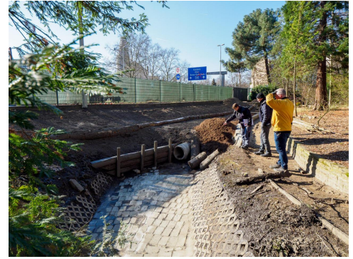
Der Melb-Zulauf wird verlegt (Foto: C. Löhne)
